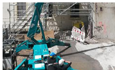
Installer charpente métallique
