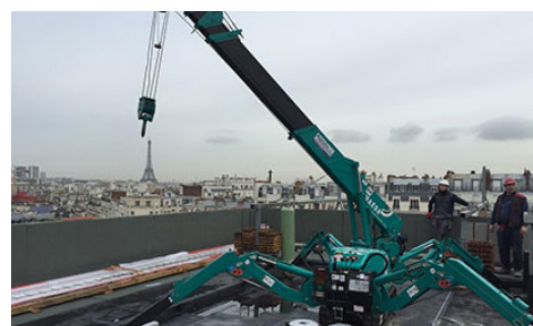
Chantier sur un toit
