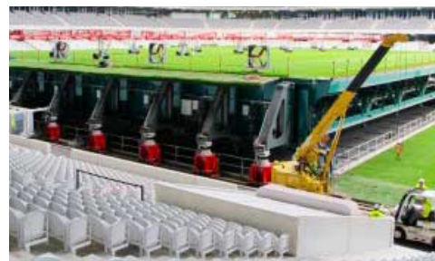
Chantier dans un stade
