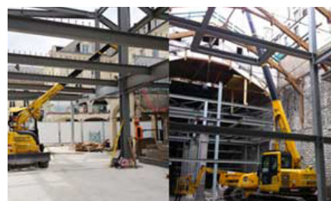
Installer une charpente métallique
