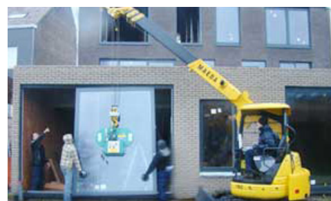
Pose vitrage lourd par temps humide
